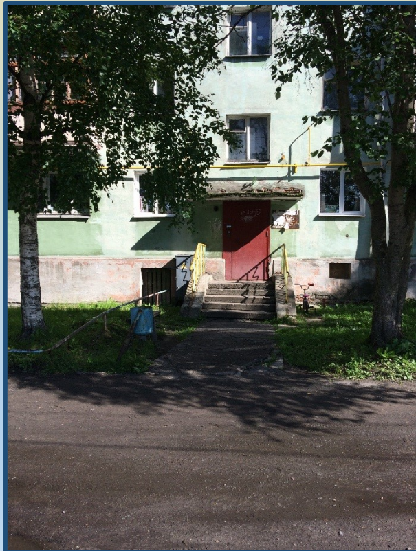
Установка скамеек и урн (до выполнения работ)
