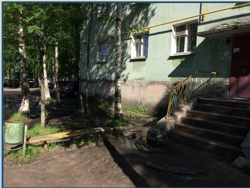
Установка скамеек и урн (до выполнения работ)
