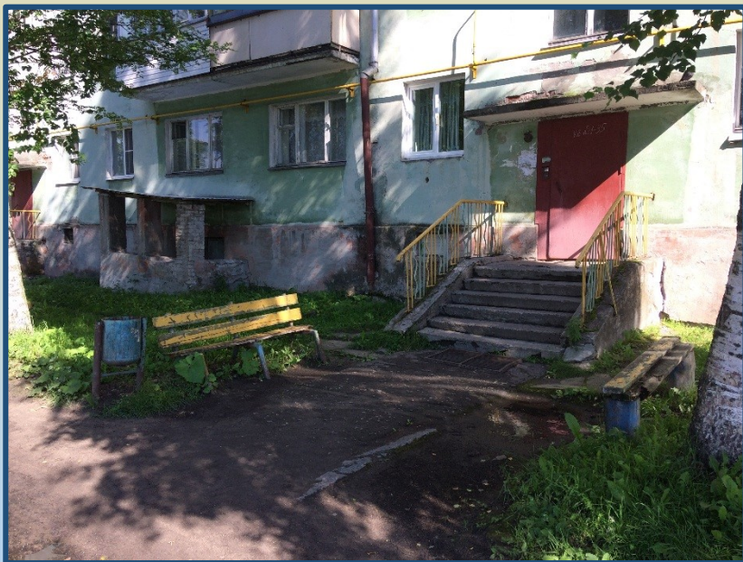
Установка скамеек и урн (до выполнения работ)
