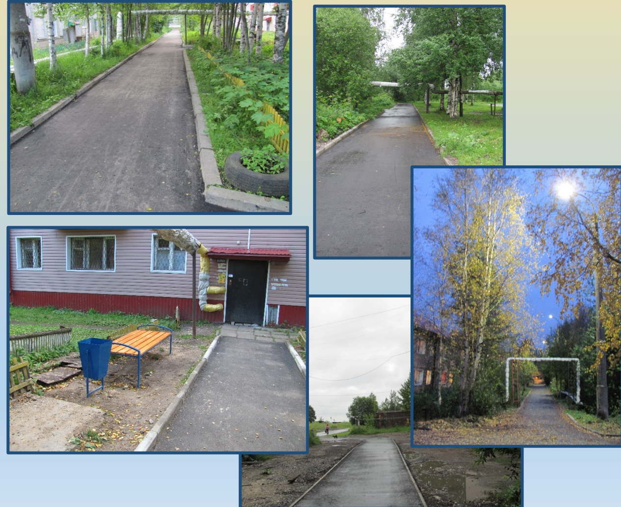
Дворовая территория после выполнения работ
